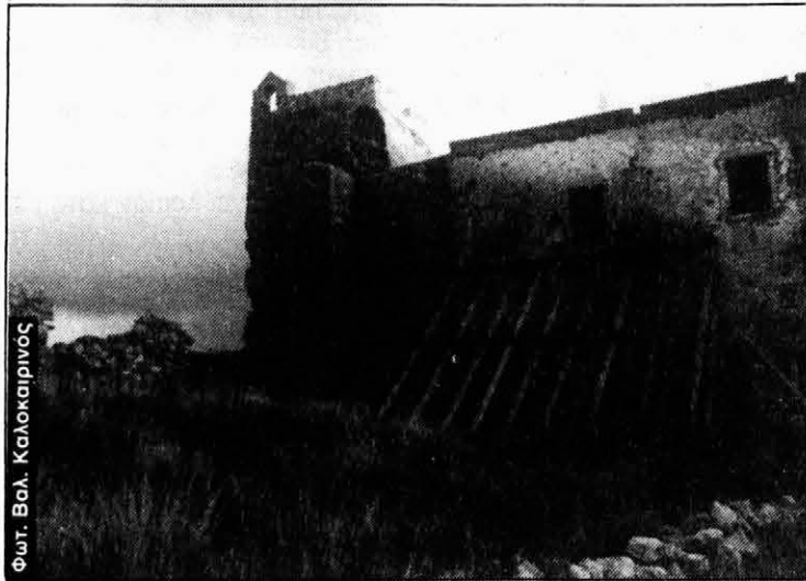
Κτίριο του κάστρου στα... χάλια του.
