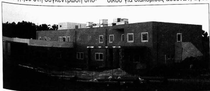
Το νέο κτήριο του Νοσοκομείου στα τέλη Αυγούστου.
