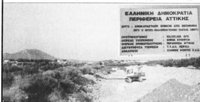
Εργασίες αποκατάστασης στην περιοχή της Παληόπολης.
