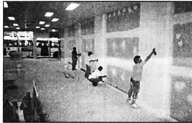
Φωτο. 2: Στιγμιότυπα από την κατασκευή του "KYTHERA HOUSE"
