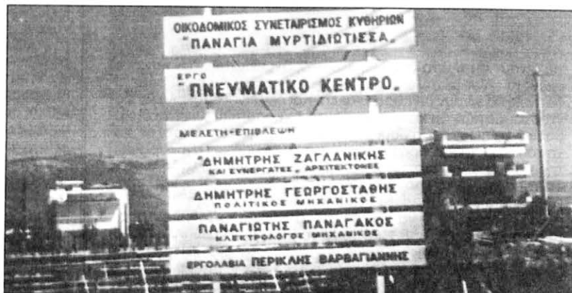
Δύο φωτογραφίες από το μεγάλο έργο που πραγματοποιείται στην περιοχή μας.
